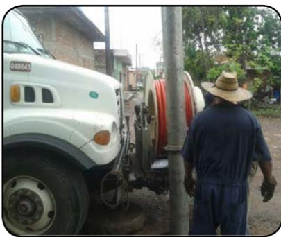
diferentes puntos de la ciudad con el camión Vector que por medio de una gran manguera absorbe y dispara chorros de agua a presión, destapando, el sistema de drenaje de la ciudad, misma que en algunos puntos tiene serios problemas por
